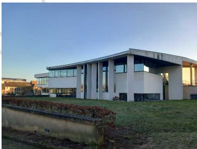
Médiathèque de Cosne-Cours-sur-Loire ©Citadia
