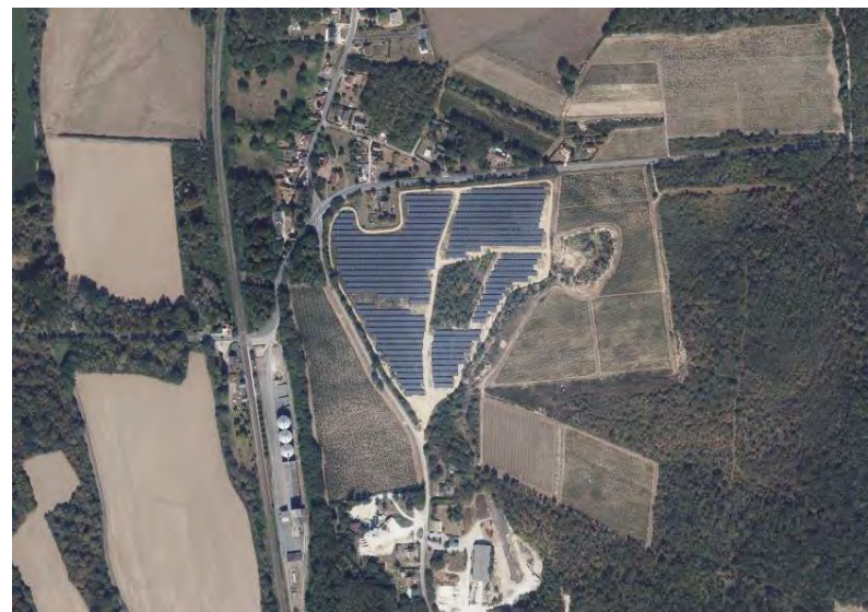
Parc photovoltaïque de Tracy-sur-Loire, vue aérienne
